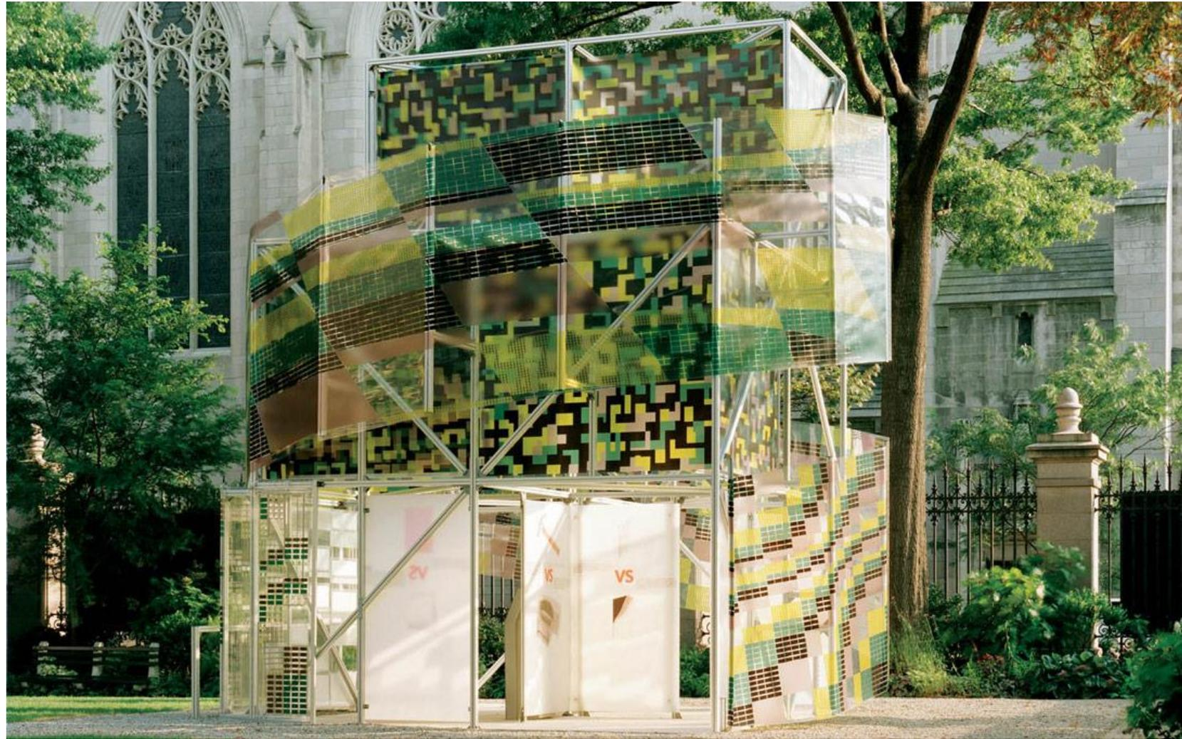
Involucro “Smart Wrap<sup>®</sup>”. Stefan Kieran e James Timberlake Architects, 2003. Le celle in thin film stampate sullo strato in PET, con la tecnologia OLED, consentono l’illuminazione dell’interno, i PCM provvedono alla regolazione microclimatica e i film di poliestere garantiscono tenuta all’acqua e al vento.
